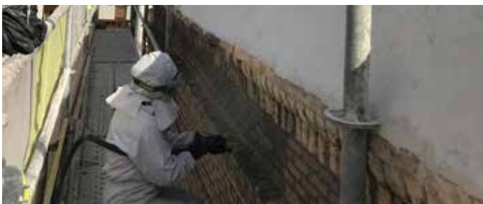
Obras en la fachada interior de la parroquia.
