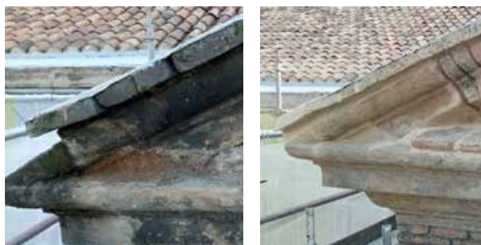
Antes y después de la intervención en uno de los tímpanos de la fachada.
