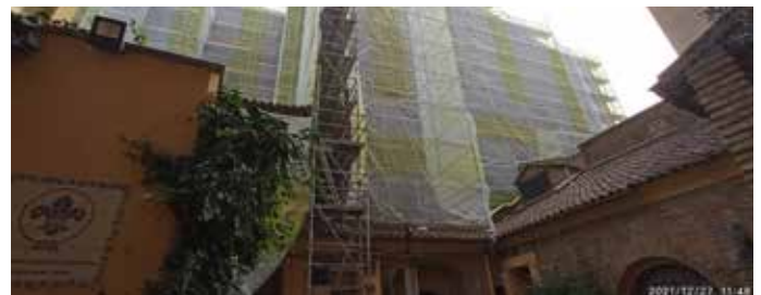
Fachada interior totalmente cubierta de andamios.
