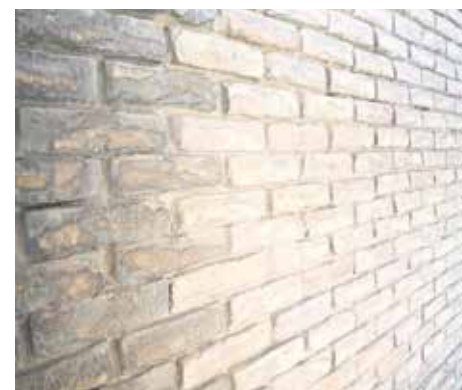
Estado previo y posterior a la limpieza que se está realizando.
