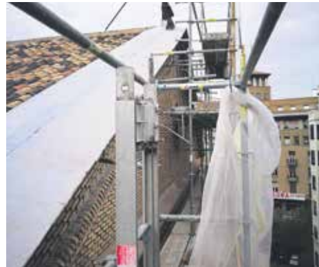
Andamios en la parte alta de la fachada, donde se han tomado las fotos.
