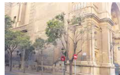
Nuestro patrimonio Obras en la fachada de D. Hernando de Aragón
